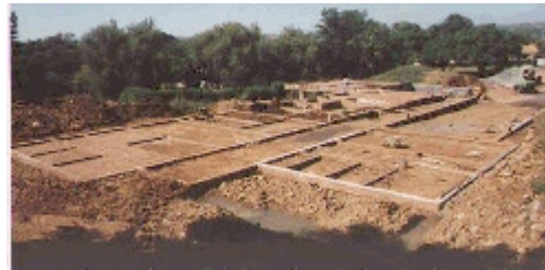
Die Fundamente des Blessed Gérard's Care Centre
